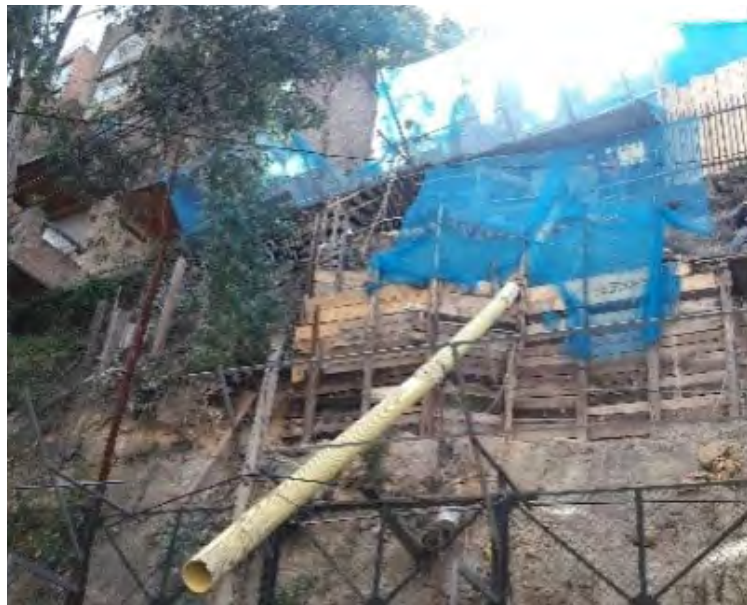
Inspección a Terreno. Localidad de Chapinero.
